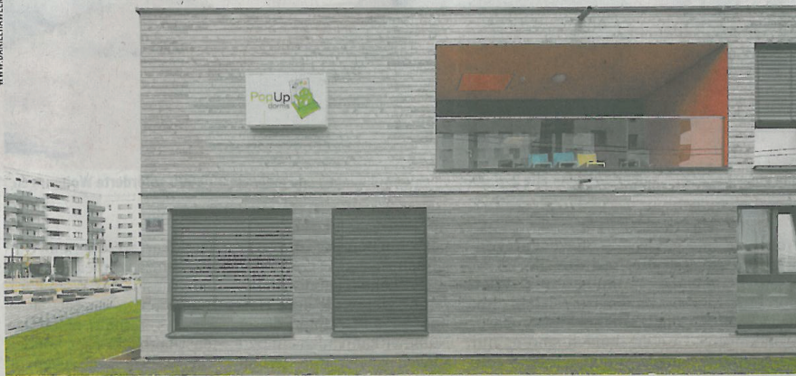
Die ersten 40 Heimplätze wurden in Holzmodulbauweise umgesetzt
